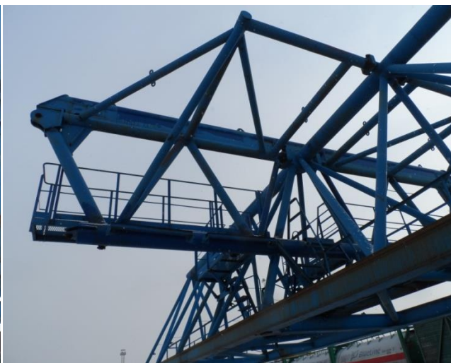
б – соединение ригеля гибкой опоры с мостом крана
