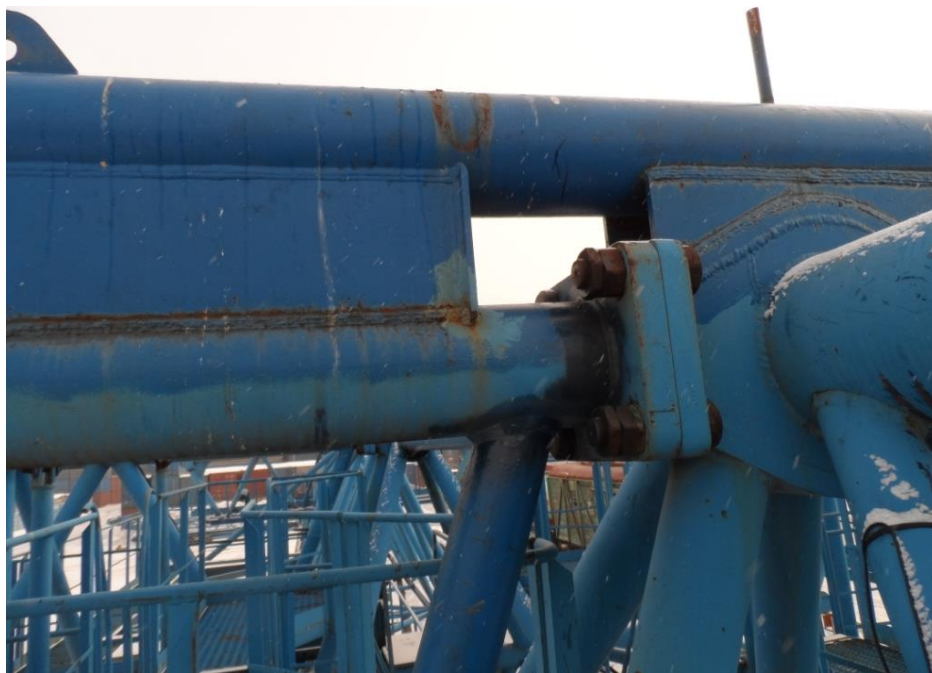
в – соединение верхнего пояса ригелей с мостом крана
